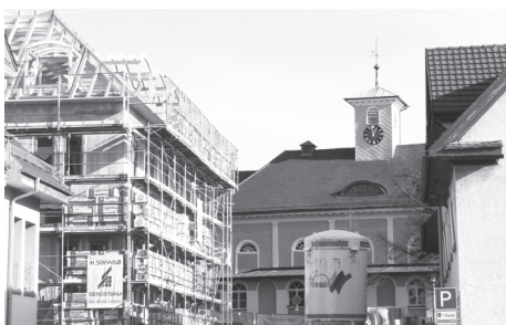
Das entstehende Gemeindezentrum der Brüdergemeinde in Korntal, 2010
