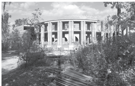
Das im Bau befindliche Gemeindehaus in Kiew
